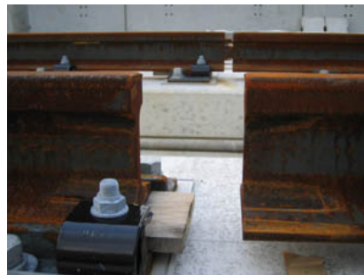
Än är glappen mellan rälisen inte hopsvetsade
